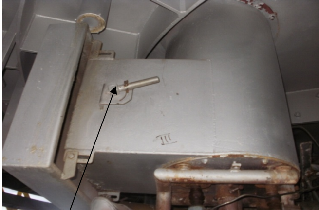
Figuur 16: Airdemper voor de brander
